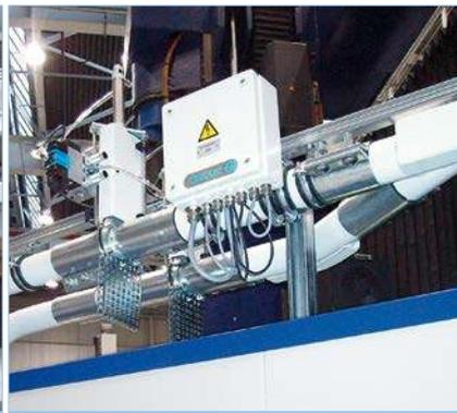
● Rohrleitungssystem mit elektropneumatischem Schieber und elektrischen Steuereinheiten
